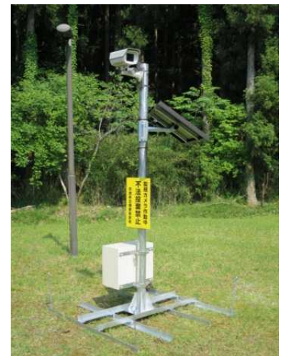
監視カメラ設置状況
